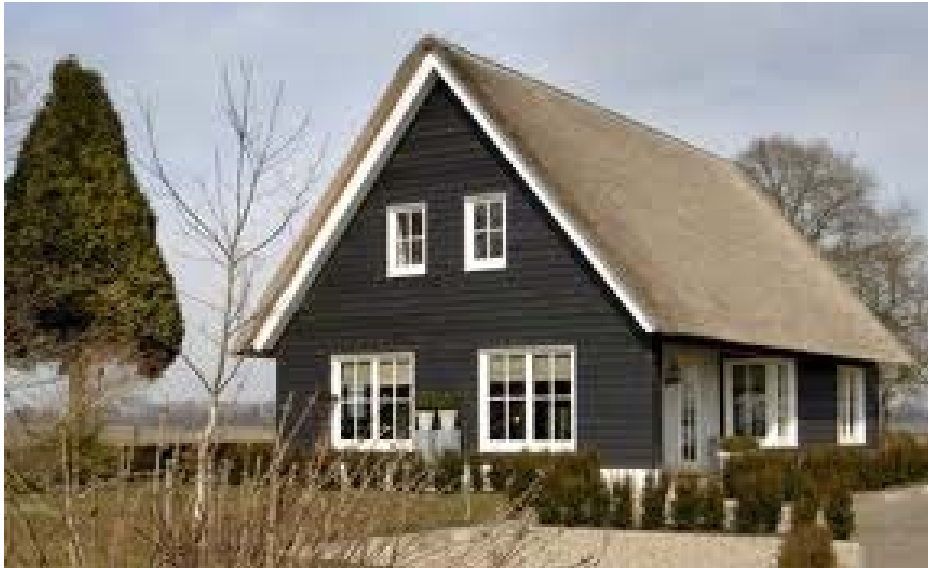
Figuur 23 Duurzaam Bouwen
